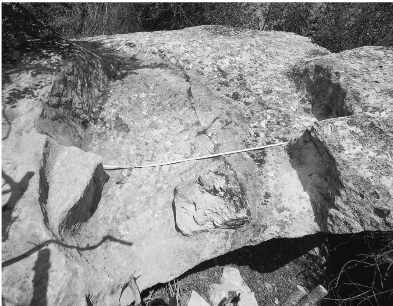
Фото 19. Рухнувший вырубной храмик у первого поворота подъездной дороги Эски-Кермена. Алтарная часть.
