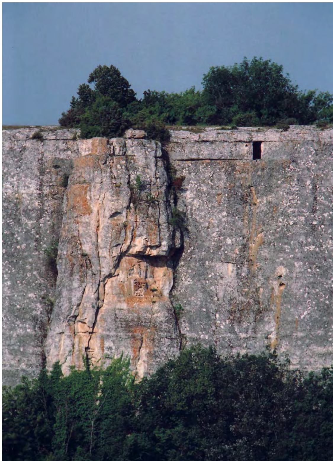
Фото 1. Вид с Тепе-Кермена на помещение №2.
