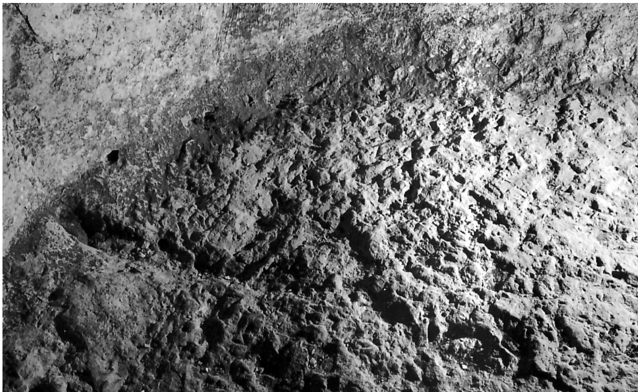
Фото 32. Подрубка в северо-западном углу пола помещения №2.
