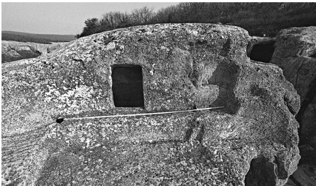
Фото 11. Церковь на западной площадке. Северная стена.
