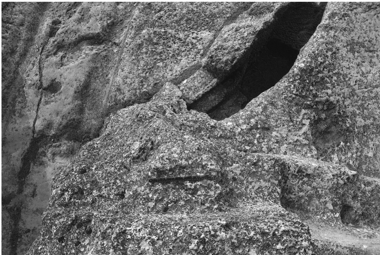
Фото 12. Церковь на западной площадке. «Постели» каменной кладки над абсидой.
