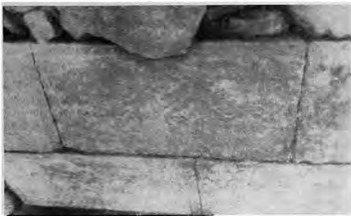
Рис. 13. Восточный фас кладки дома IV в. до н. э. № 43, сложенный из рустованных блоков
