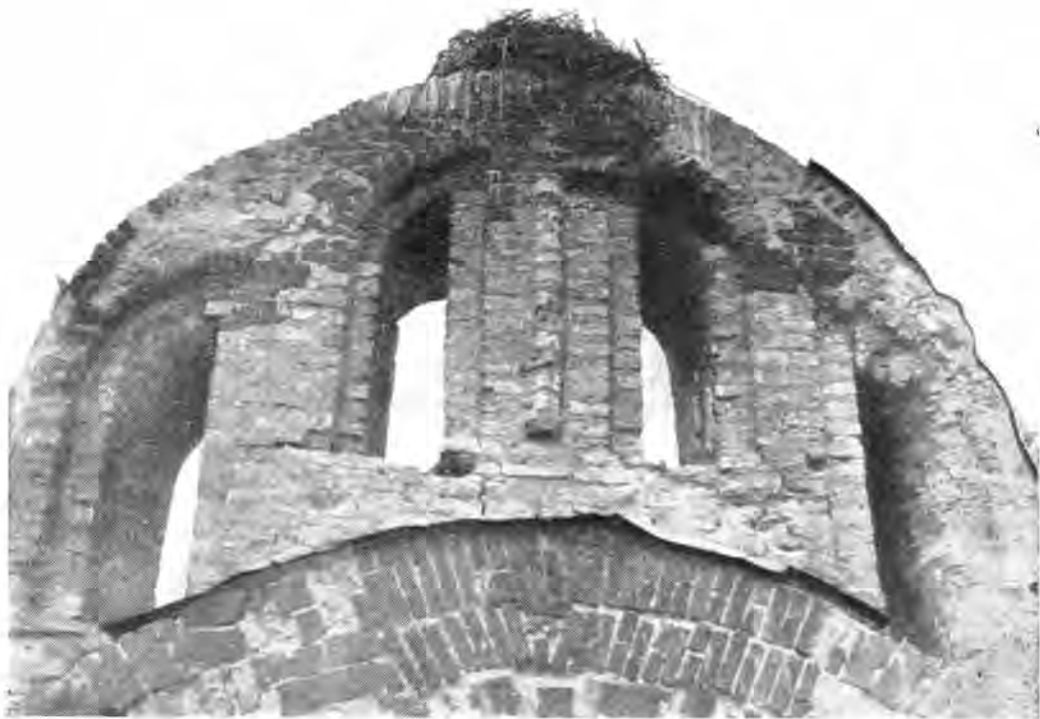
Рис. 7. Центральная закомара восточного фасада
