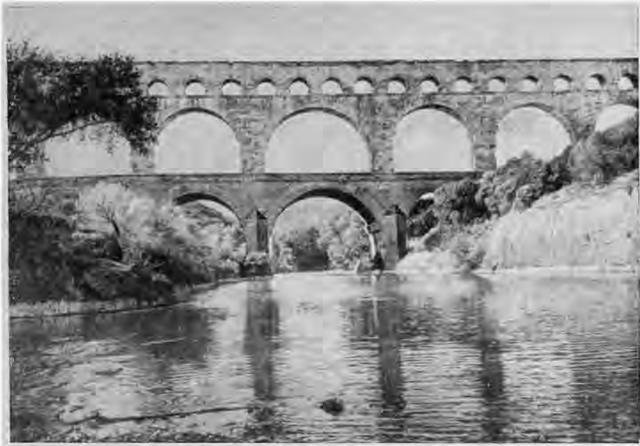
Рис. 1. Общий вид Гардского моста с западной стороны
