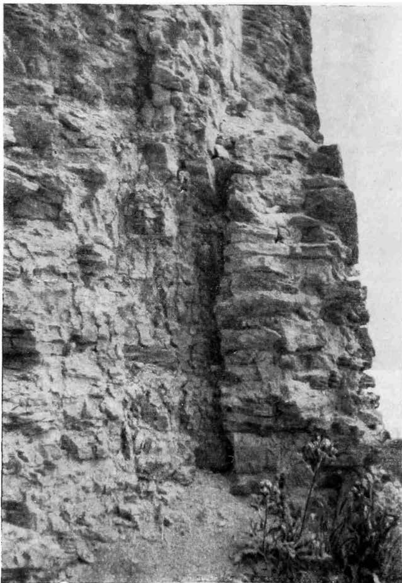
Рис. 4. Копорье. Уступ юго-западной стены близ северо-западной башни
