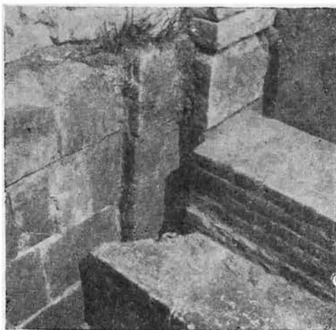
Рис. 3. Стык основания галереи с юго-восточным углом храма
