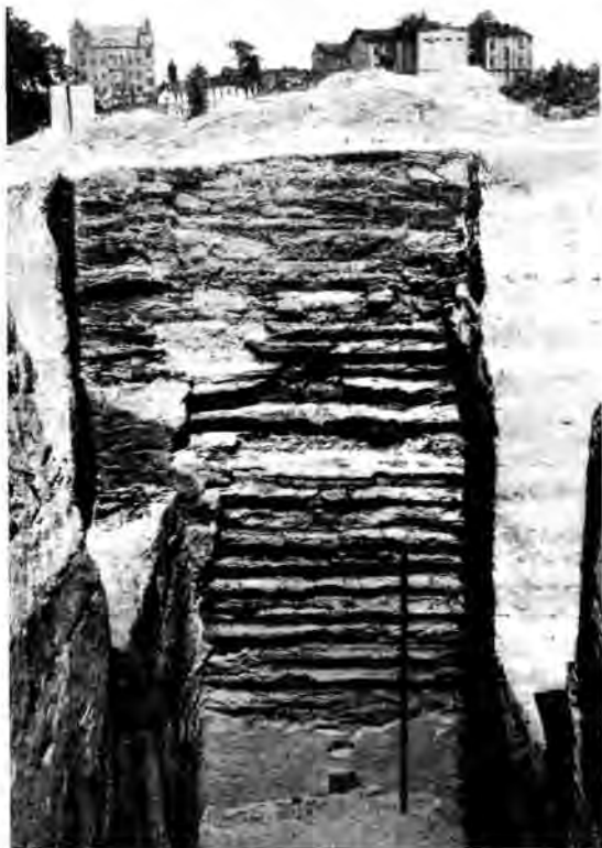
Рис. 24. Сруб оборонительного вала XI в. в Киеве
