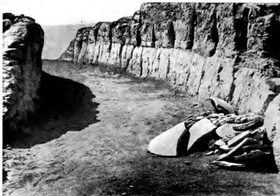
Рис. 14. Обходный коридор на центральной площадке Кой-Крылган-кала
