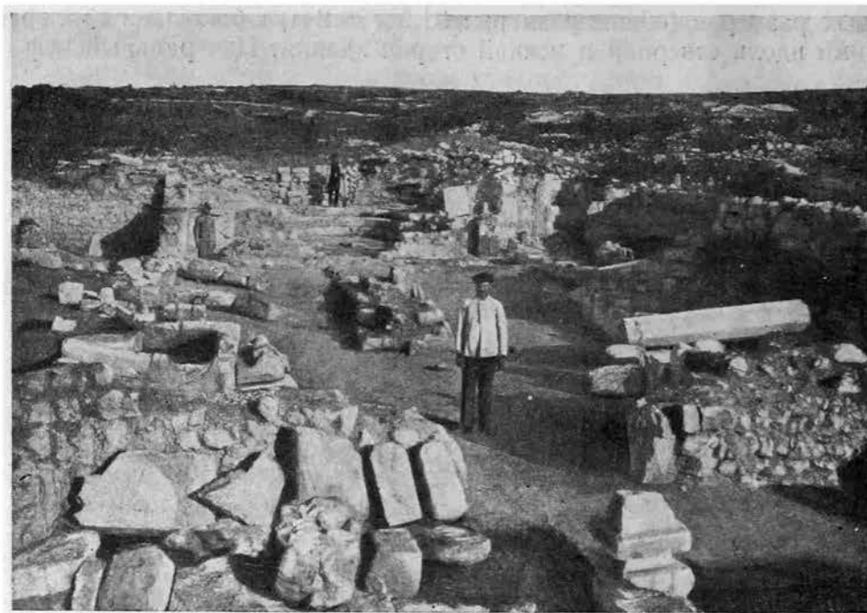
Рис. 2. Общий вид базилики с западной стороны.
