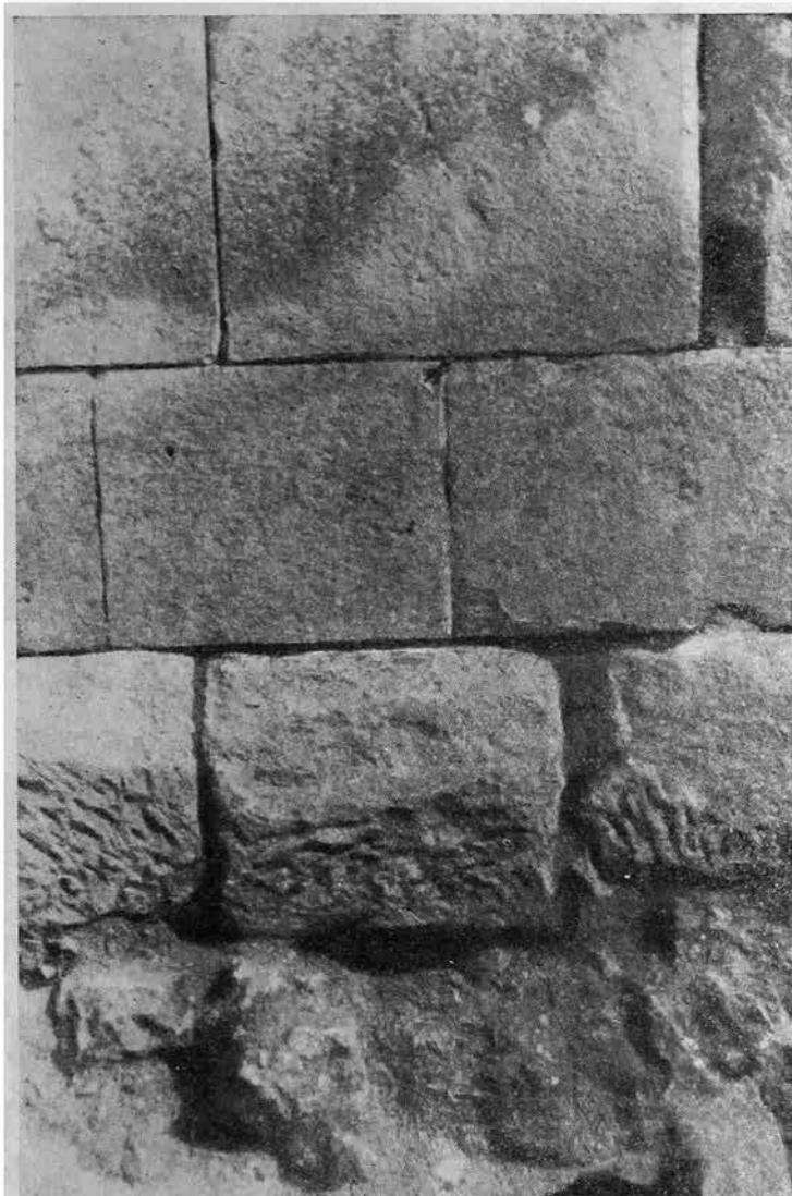
Рис. 4. Деталь кладки западной стены базилики.
