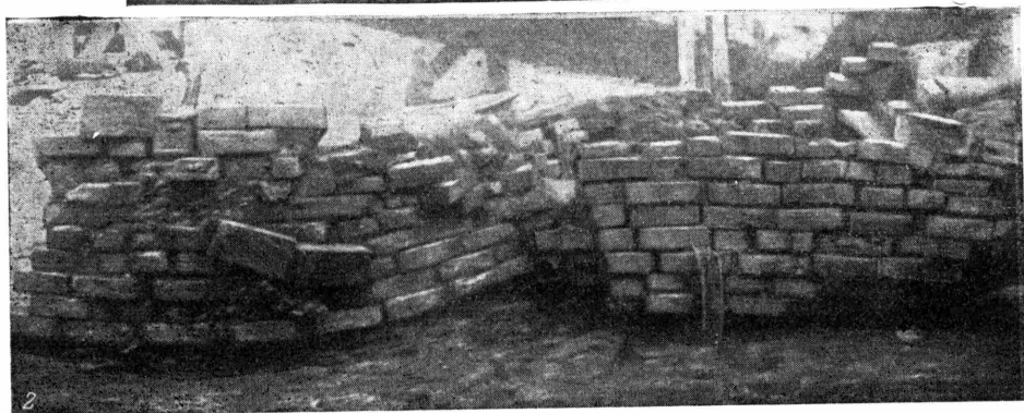
Рис. 47. Раскопки в Зарядье. Кирпичное производственное сооружение.
