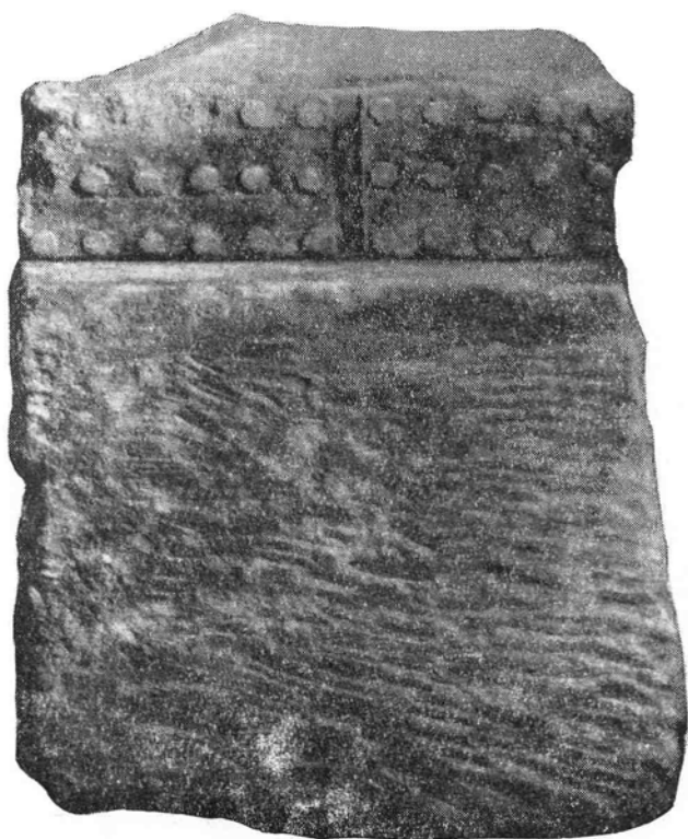
Рис. 27. Плита карниза с росписью красной краской на выносной плите и синей на мутулах
