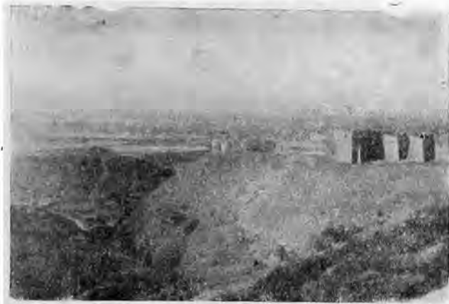
Рис. 4. Овраг у западной стены цитадели.
