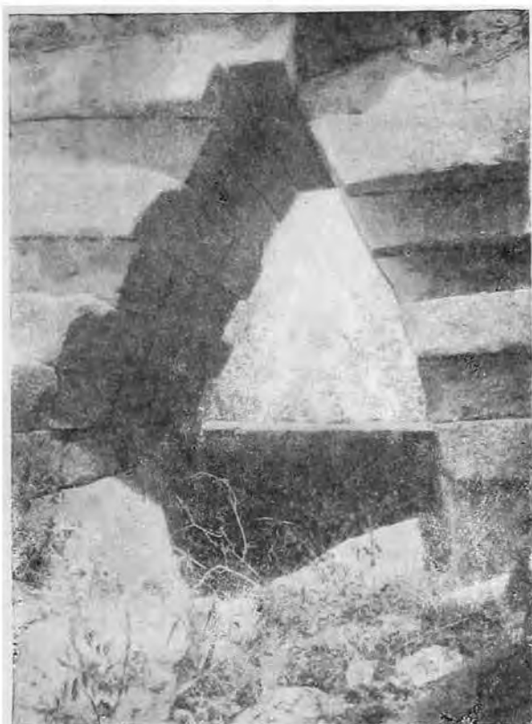
Рис. 20. Башня горной стены.
