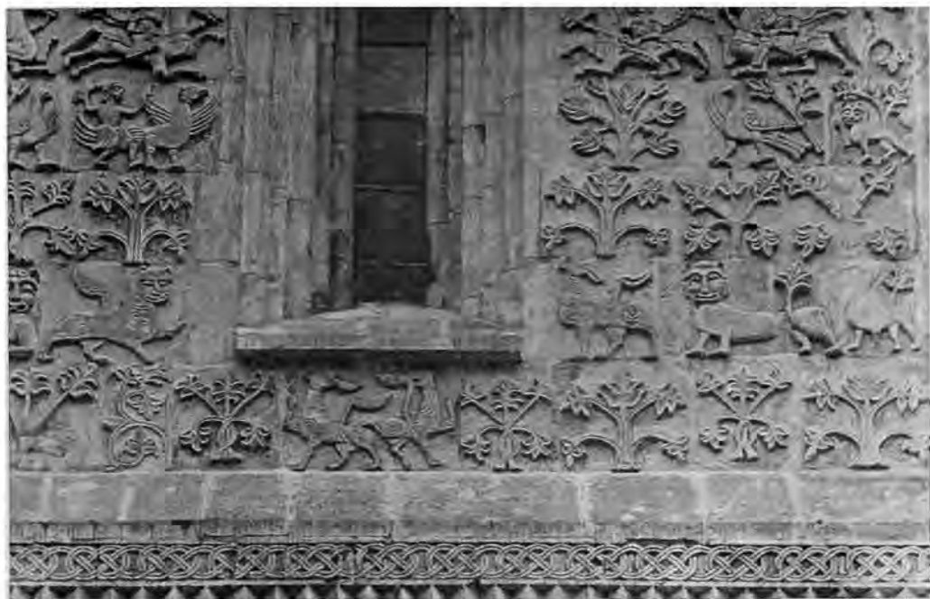
Рис. 3. Рельефы центрального прясла западного фасада (1—5-й ряды). Дмитриевский собор во Владимире (фото автора)
