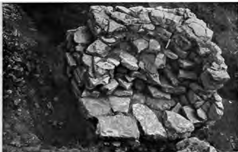
Рис. 8. Основание винтовой лестницы
