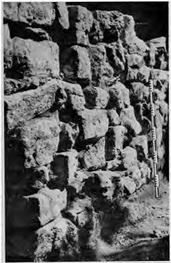
Рис. 6. Лицевая кладка той же стены
