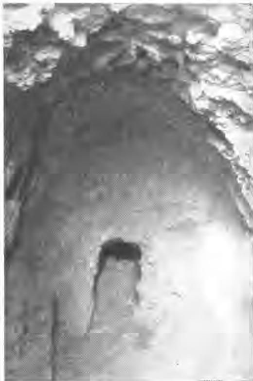
Рис. 2. Печь № 3. Свод топочной камеры. В проемине видна первоначальная кладка торцовой стены
