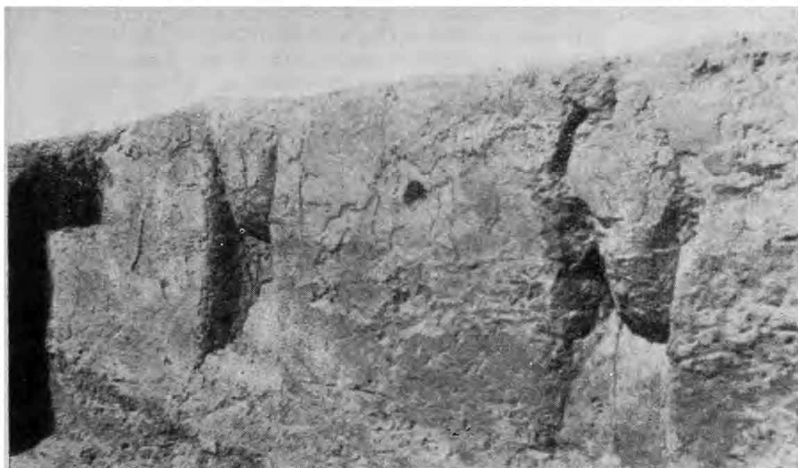
Рис. 2. Северная стена помещения 10
