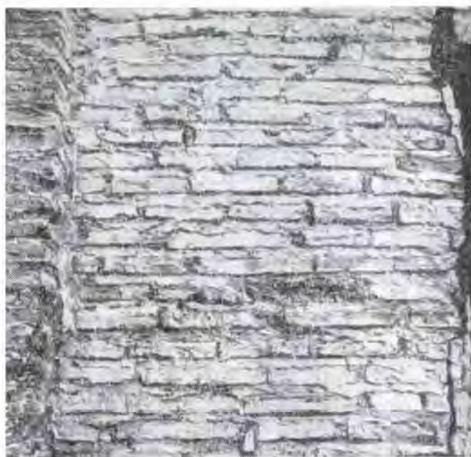
Рис. 2. Церковь Иоанна Богослова. Деталь кладки
