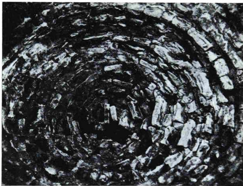
Рис. 5. Каменная кладка купола изнутри
