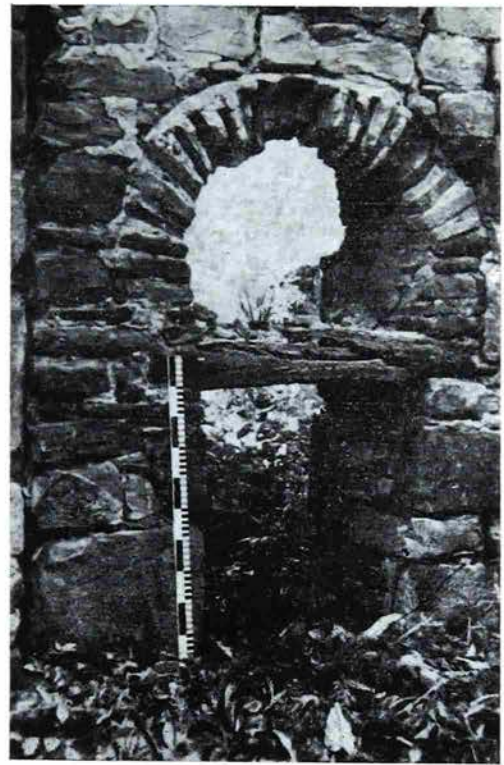
Рис. 7. Дверной проем с люнетом в северной стене нартекса
