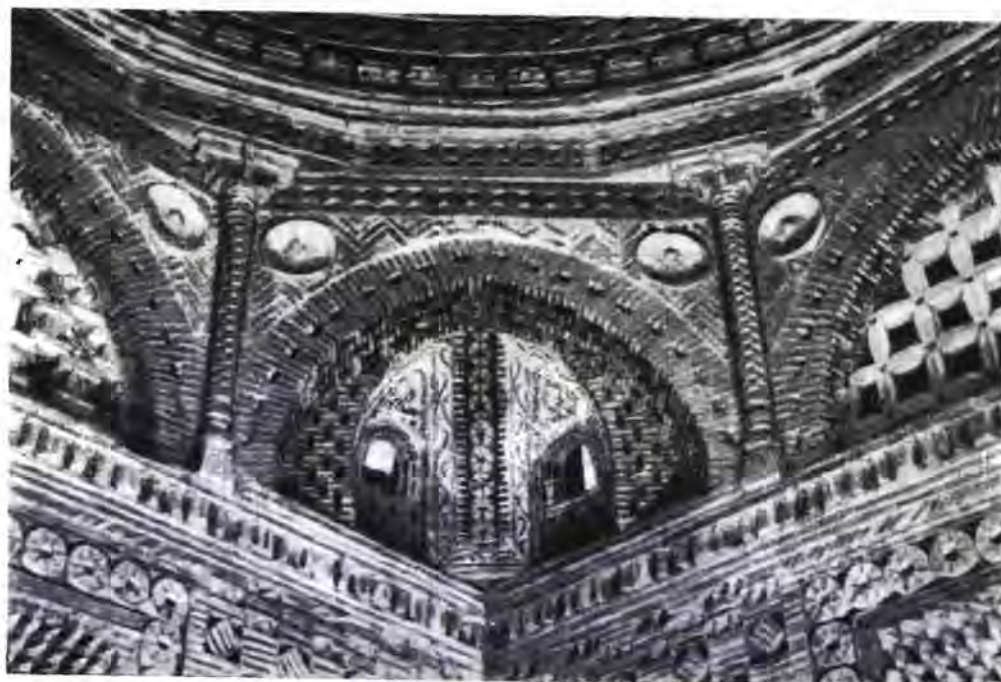
Рис. 9. Подкупольная конструкция мавзолея Саманидов
