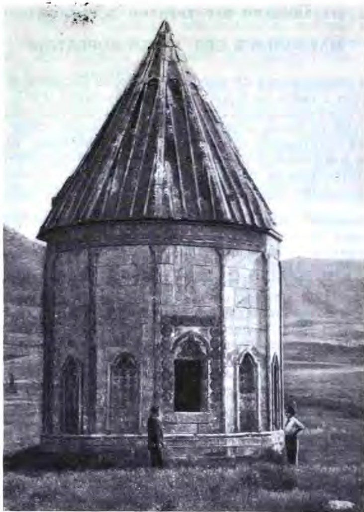
Рис. 1. Мавзолей в сел. Хачен-Дорбатлы 1314 г. Устад Шахенги. Северный фасад
