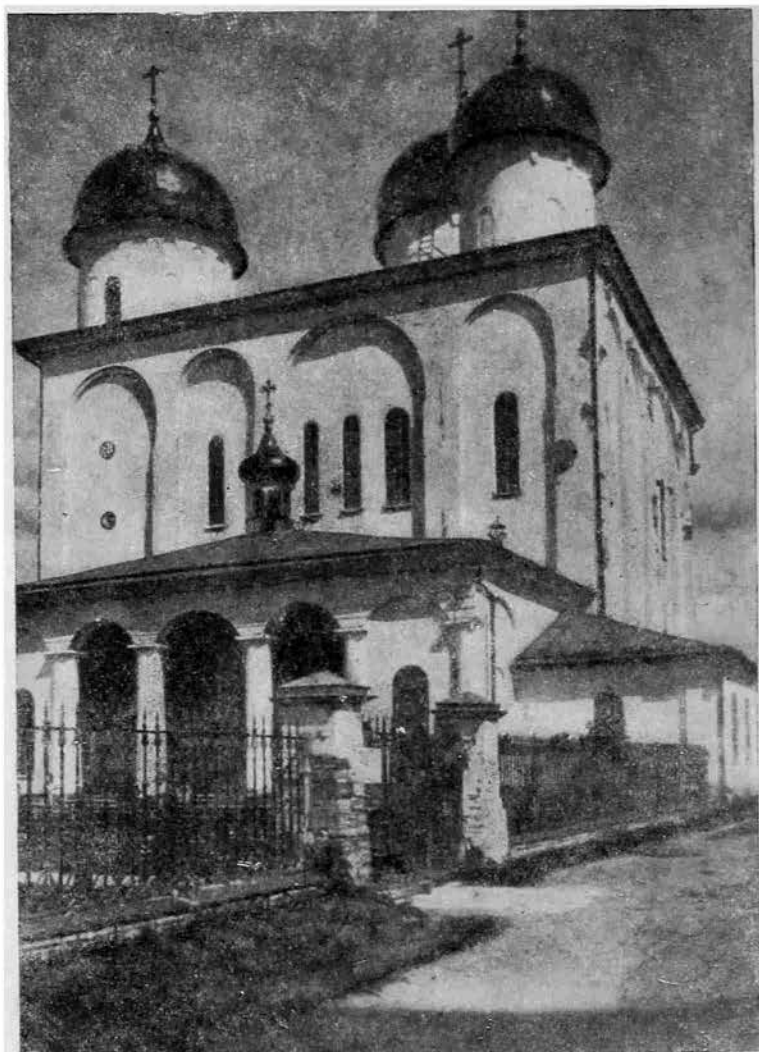
Рис. 18. Западный фасад (до реставрации).
