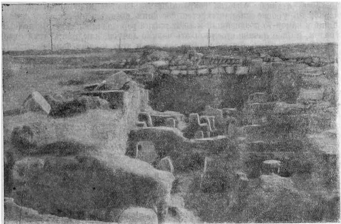
Рис. 4. Баня IX—X вв. в III квартале Херсонеса с северо-западной стороны.
