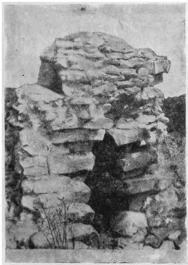
Рис. 21. Башня горной стены.
