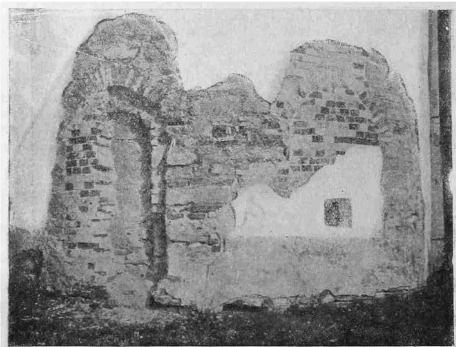
Рис. 5. Ниши на северной апсиде (в процессе расчистки).
