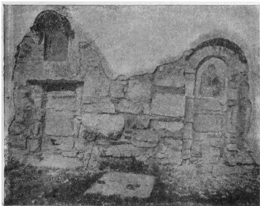
Рис. 3. Ниши на центральной апсиде (в процессе расчистки).
