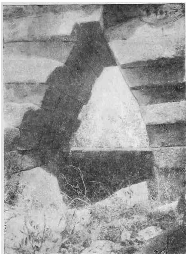
Рис. 20. Башня горной стены.
