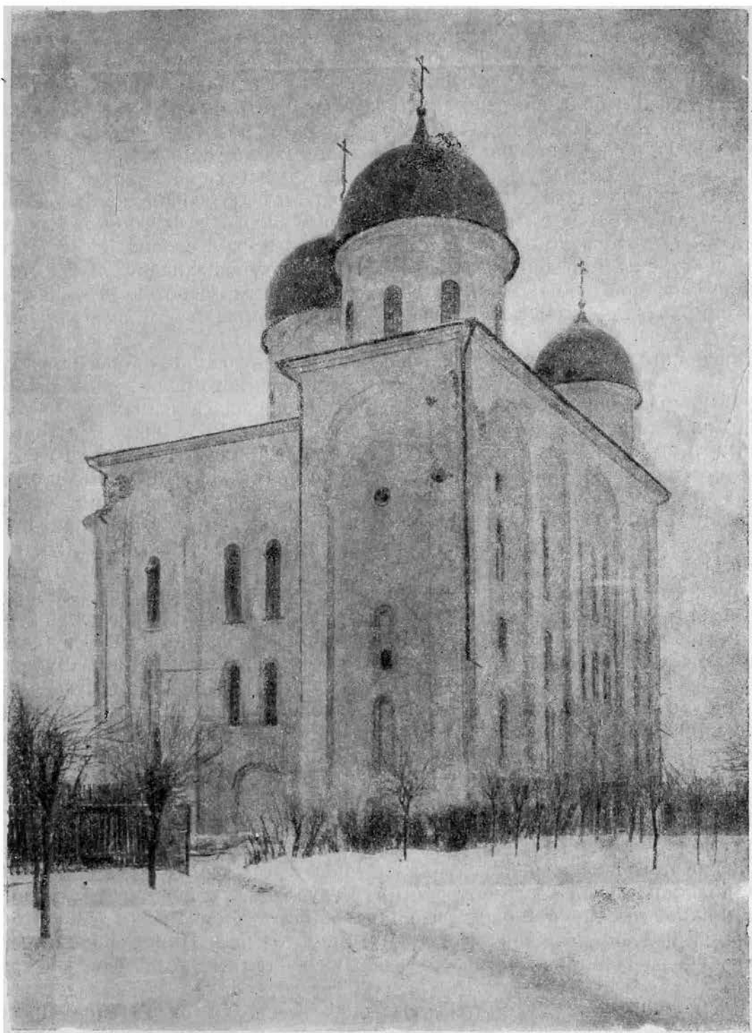
Рис. 21. Северо-западный угол собора (после реставрации).
