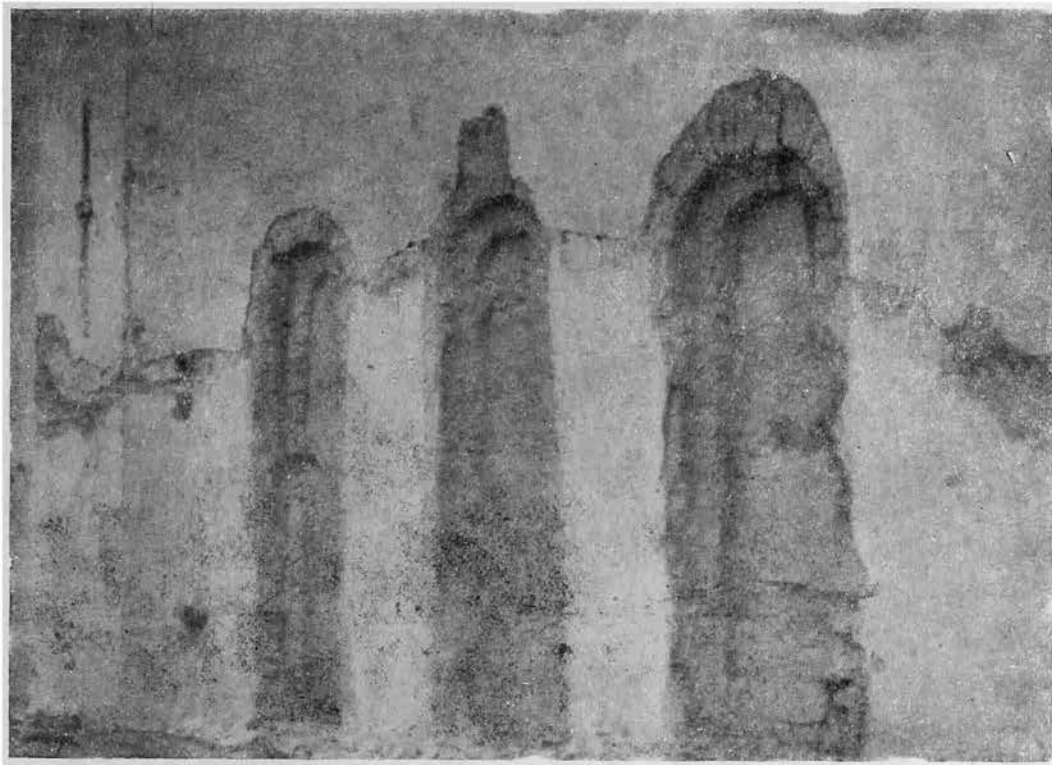
Рис. 19. Ниши на западном фасаде (в процессе расчистки).
