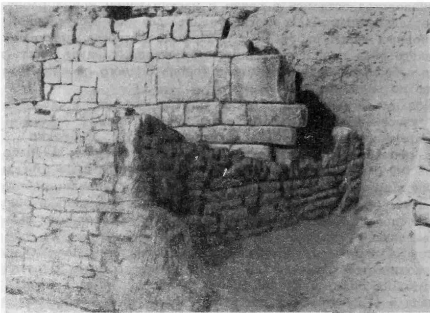
Рис. 28. Угол помещения с сырцовыми стенами (V в. до н. э.) и находящаяся за помещением подпорная стена (III в. до н. э.)
