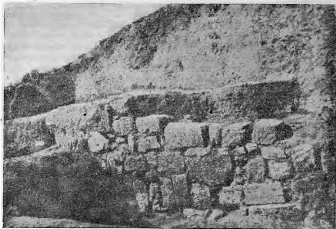
Рис. 30. Пантикапей. Раскоп 1945 г. Подпорная стена
