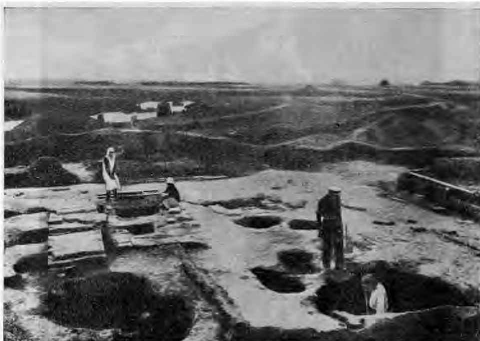
Рис. 15. Остатки деревянных построек X в. в крепости.
